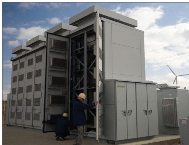
Fig. 2 - Installazione di un pacco batterie a ioni di sodio sul retro di una fattoria americana. Queste batterie immagazzinano l'elettricità prodotta dalle pale eoliche poste sul perimetro della fattoria. Foto: CNET
