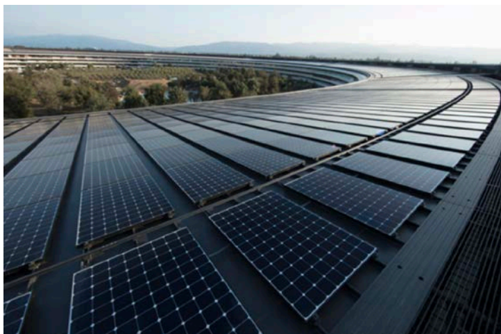
Fig. 16 - Il centro direzionale della Apple a Cupertino (California) è alimentato totalmente da energie rinnovabili provenienti, in parte, dal fotovoltaico installato sul tetto che fornisce 17 MW
