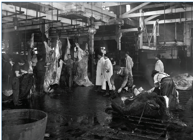
Fig. 4 - Condizioni dei macelli del 19° secolo negli USA (Library of Congress)
